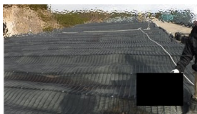
図2 ジオグリッド敷設後の様子 (撮影後、上に通気性防水シートを敷設)
